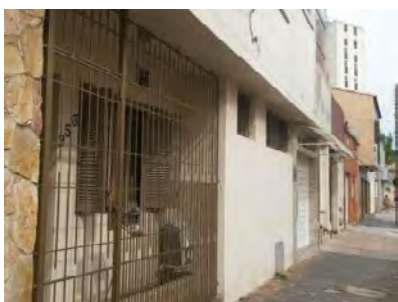
Figura 4 – Fotografia da fachada de uma casa no Centro, Rio Grande - RS. Fonte: Fotografia própria, outubro, 2017.
