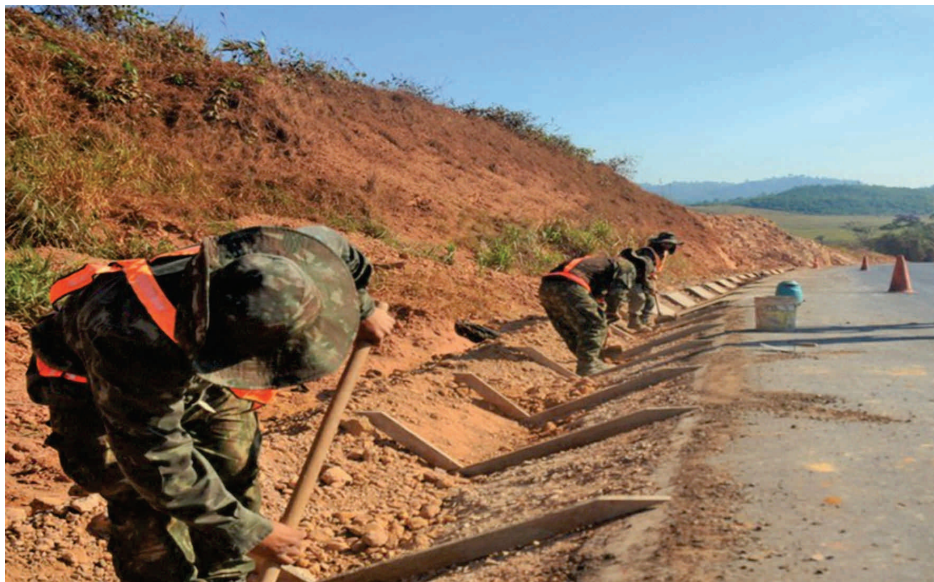
FIGURA 9 – HOMENS DO 8º BEC TRABALHANDO NAS OBRAS DE “FINALIZAÇÃO” DA BR-163. Fonte: Governo do Brasil (2020).
