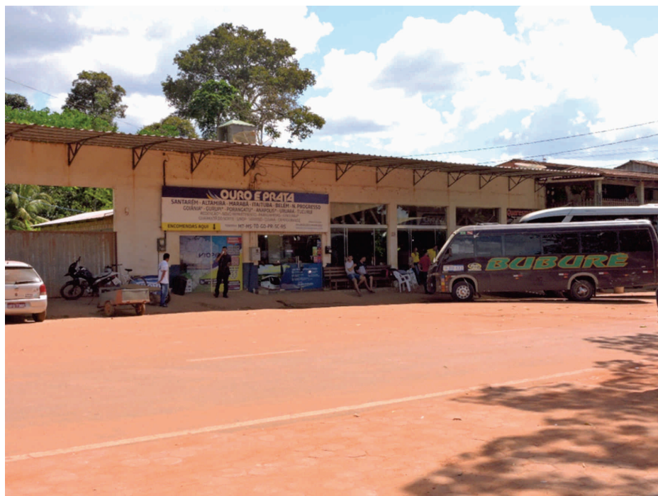
FIGURA 2 – TERMINAL RODOVIÁRIO DE RURÓPOLIS
