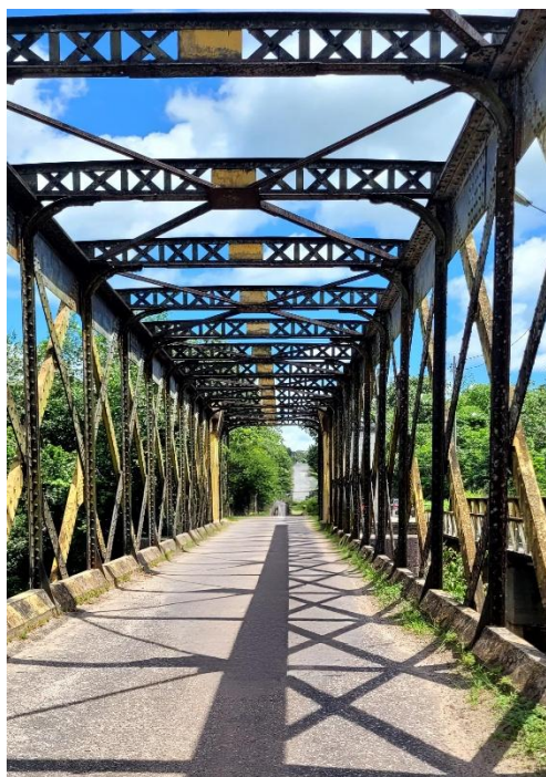
Figura 5- Ponte de Ferro do Livramento
