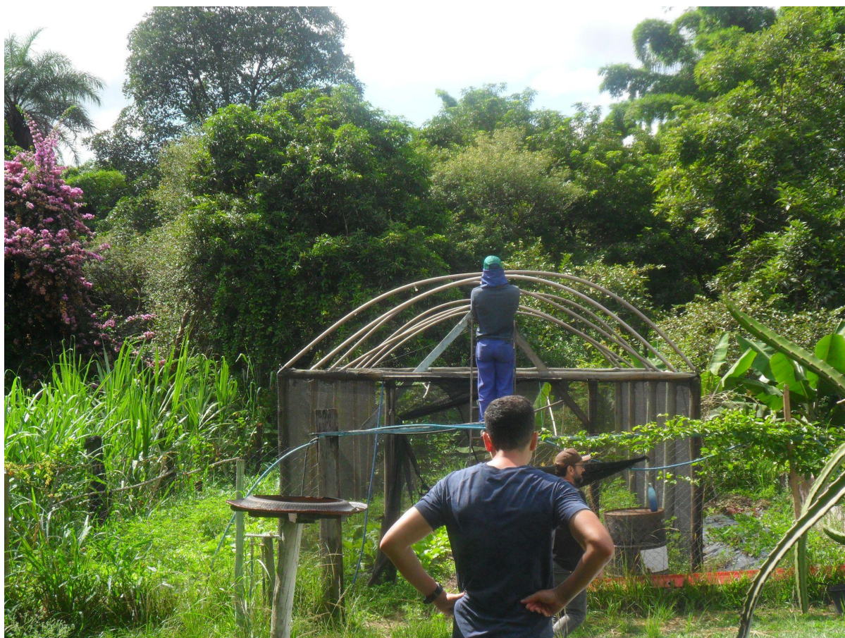
FIGURA 3 - Construção da Estufa.
