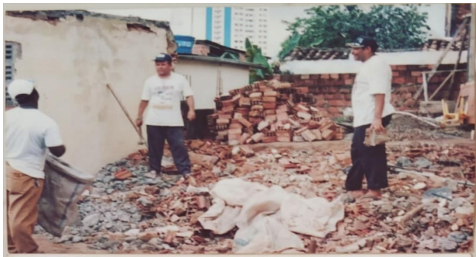
Figura 1: Retirada de escombros do processo de reconstrução do imóvel doado para a Igreja.
