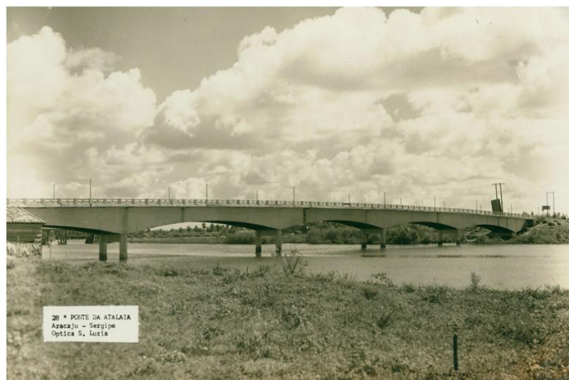
Figura 02 – Fotografia da ponte Juscelino Kubitschek sobre o Rio Poxim, 1957. Fonte: Diniz, 2009.
