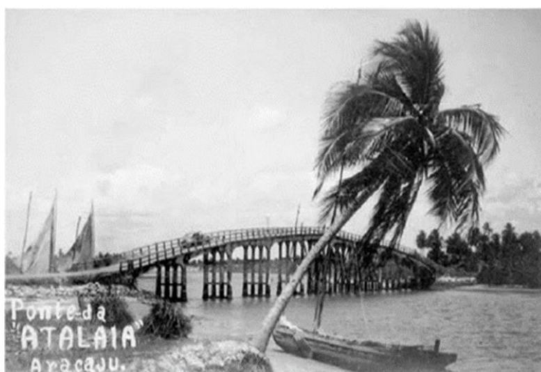
Figura 01- Fotografia da primeira ponte de ligação entre Aracaju e Atalaia. Fonte: Diniz, 2009.
