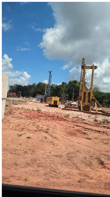
Figura 1: Trecho da obra da Avenida Liberdade, 2025.
